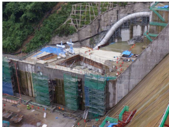
利水放流設備工事
