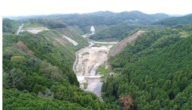
下流締切完成 (H30.8)
