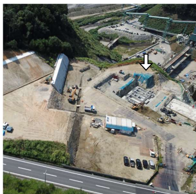
管理棟工事現場
