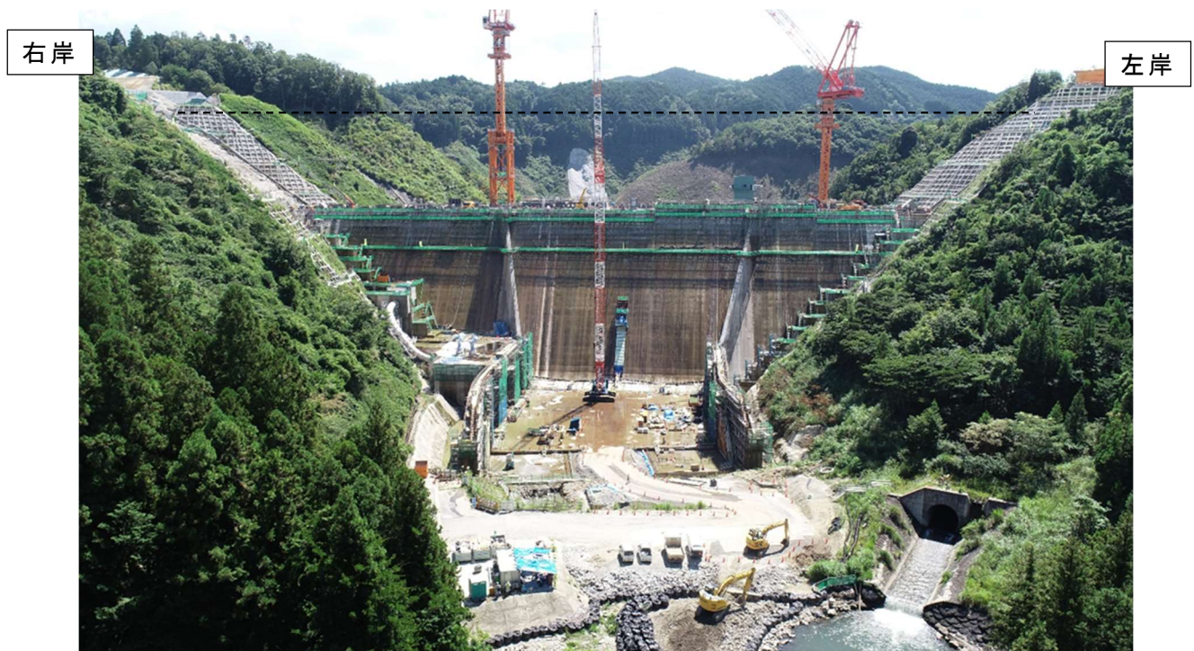
ダム下流より堤体を望む
